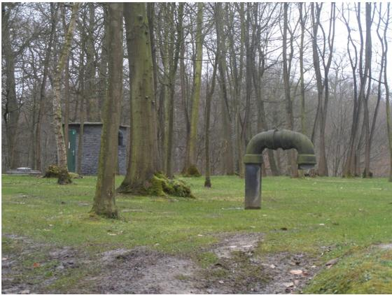
les buses permettent d'aérer les réservoirs.
