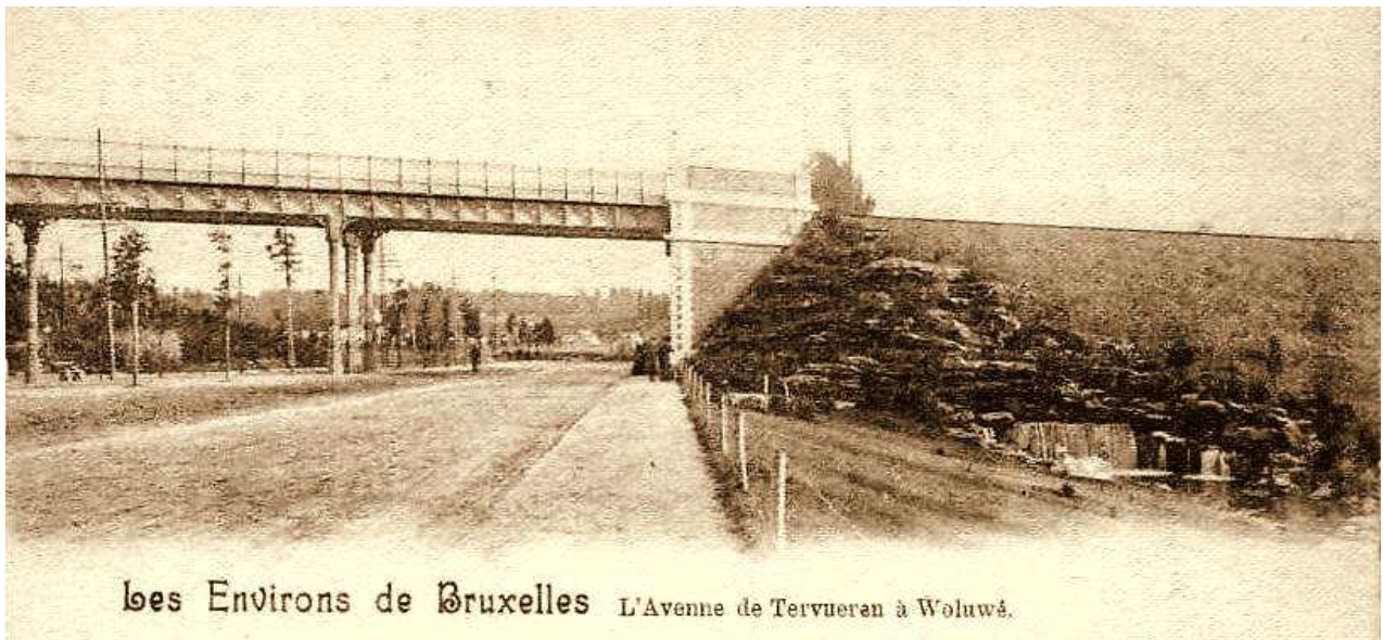
Pont du chemin de fer Quartier Léopold – Tervueren au-dessus de l'avenue de Tervueren
