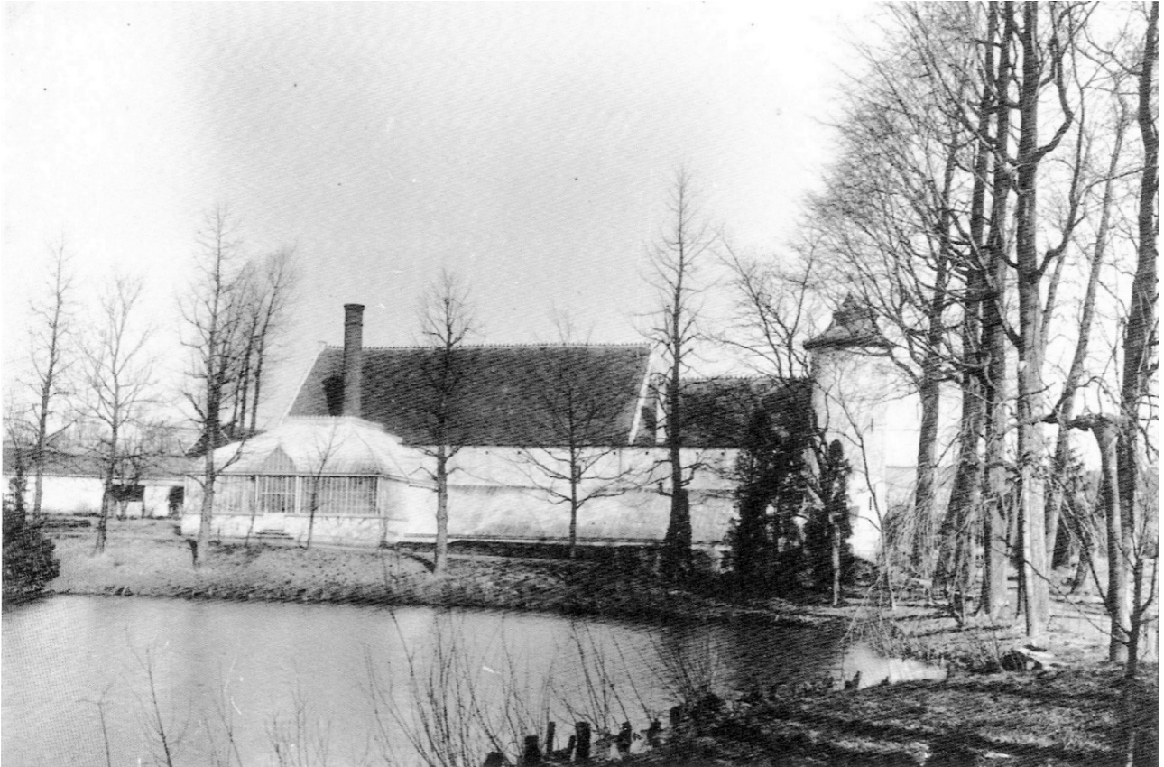
La tour ronde et la serre, dépendances du château du Bemel avant sa destruction en 1989 (B3)
